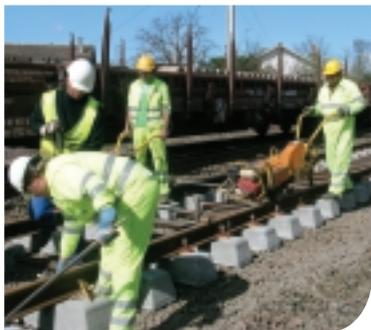
Cette opération consiste à remplacer les traverses et les rails. Les anciens rails sont démontés puis écartés de la voie par un train de substitution. Les vieilles traverses sont enlevées et remplacées immédiatement par des nouvelles en béton. Les nouveaux rails d'une longueur de 400 m sont fixés sur les traverses neuves.
