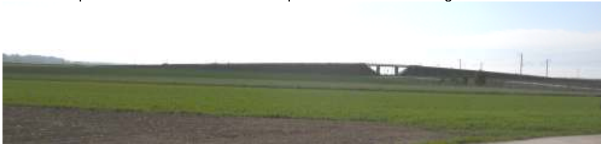
Exemple de rétablissement d'une route départementale par un pont route sur la LGV Est Européenne
