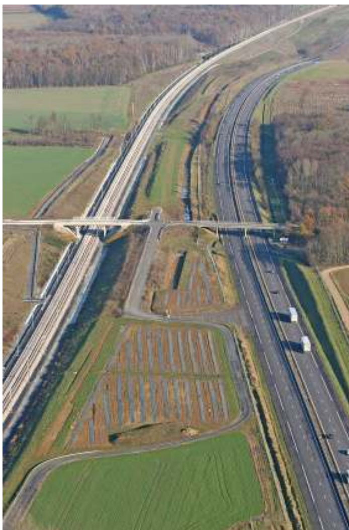
Exemple de voisinage entre la LGV Est et l'autoroute A4 avec mise en place d'un merlon et mutualisation du rétablissement de la voirie.
