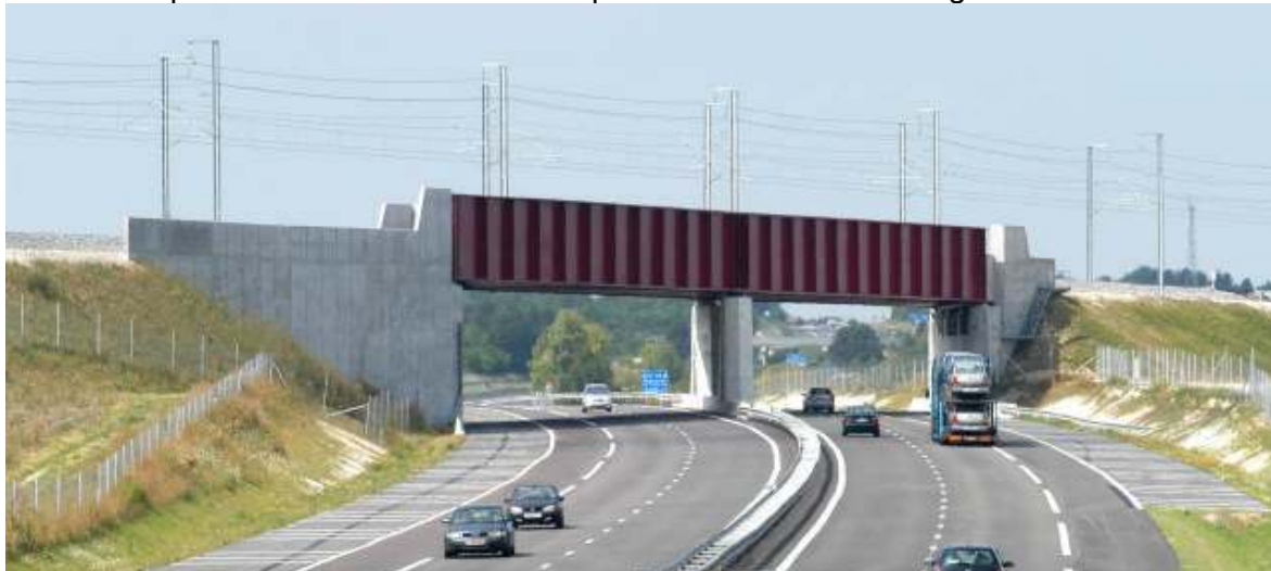
Exemple de rétablissement par un pont rail de l'autoroute A4 sur la LGV Est Européenne
