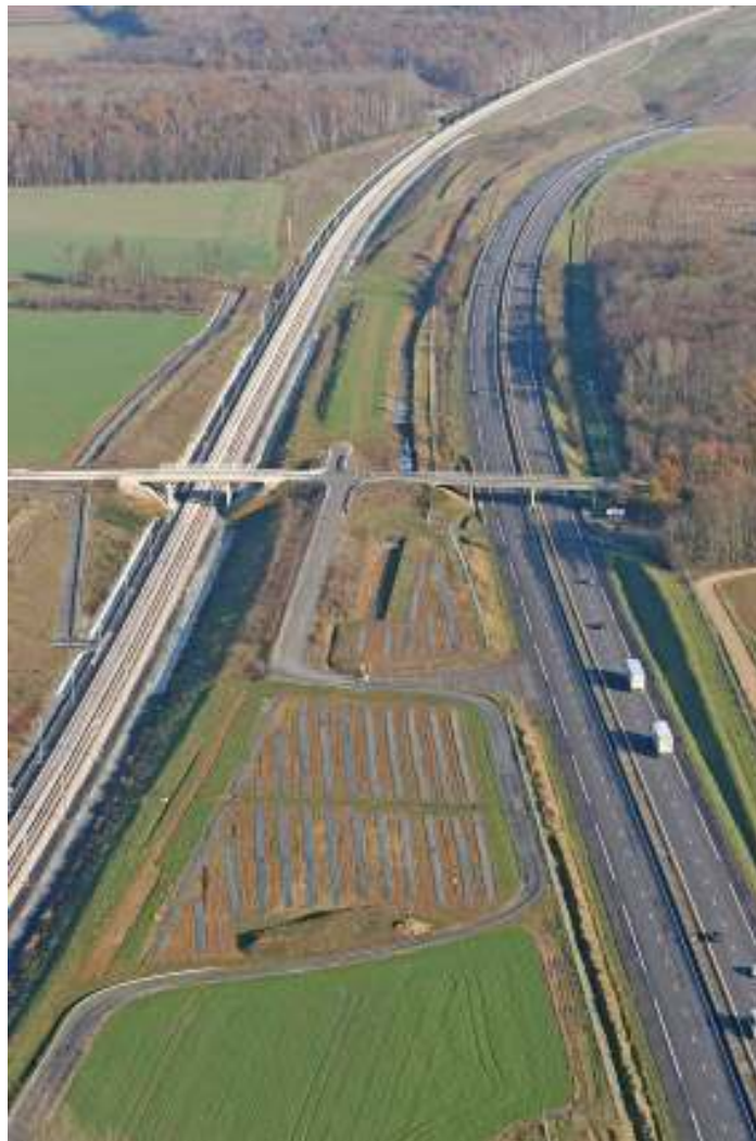
Exemple de voisinage entre la LGV Est et l'autoroute A4 avec mise en place d'un merlon et mutualisation du rétablissement de la voirie.
