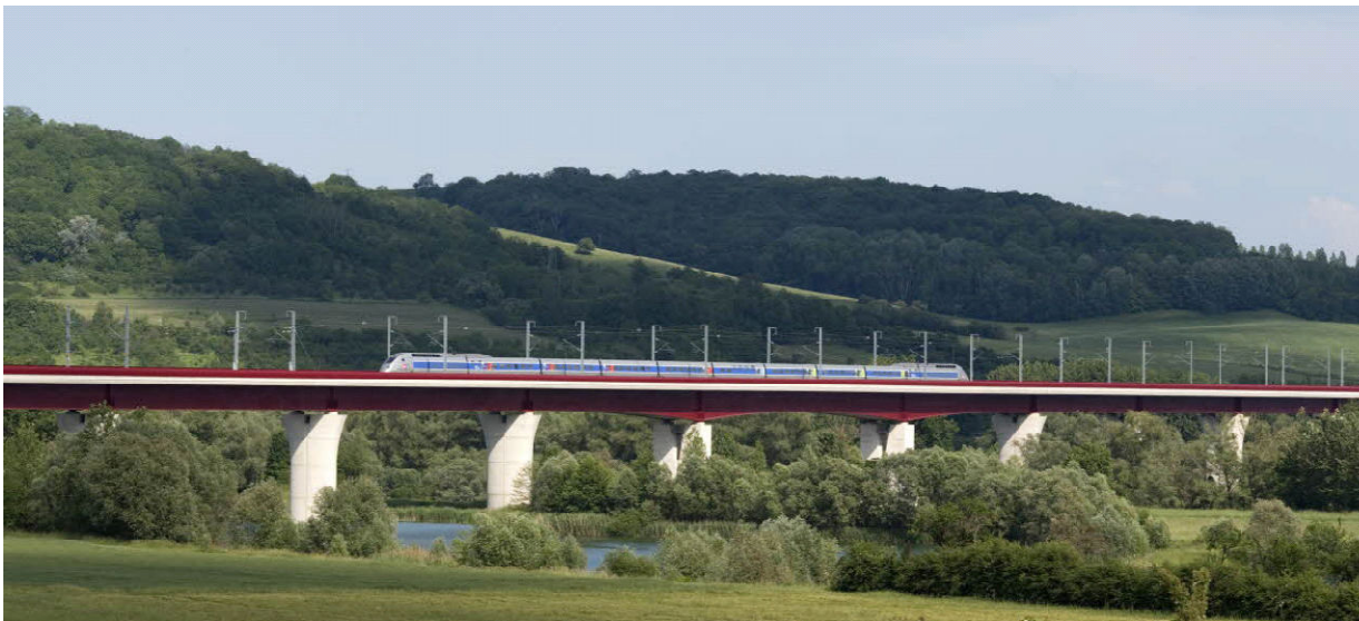
Viaduc et bassin multifonctions
